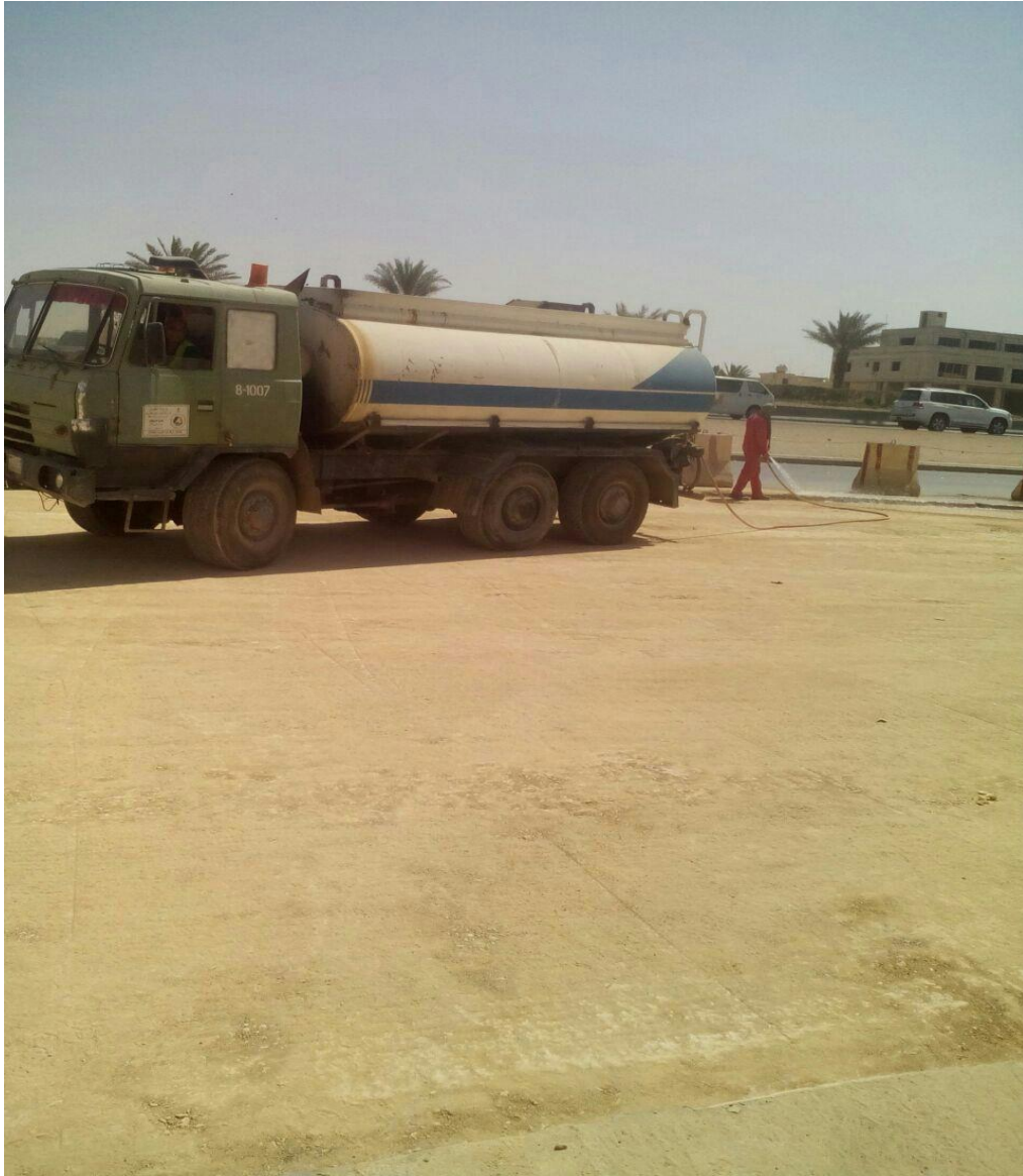
صورة لرشاش الماء وكمية الرش بنسبة لا تزيد عن ٦%
